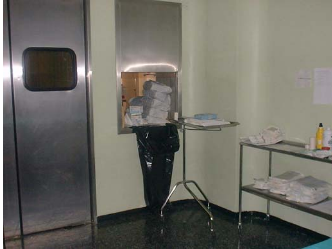
Fig. 12. Sala de almacenaje
